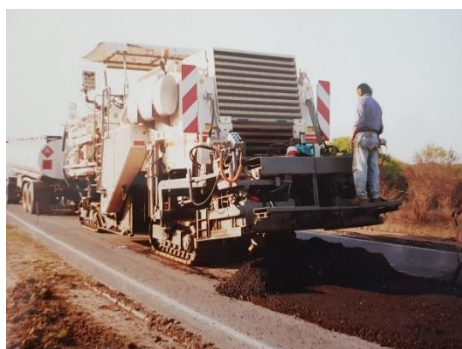
Figura 11. Reciclado in situ con emulsión, Ruta 81, Formosa, 1987
